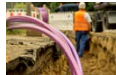
12 bar: Kabelblazen en boren
