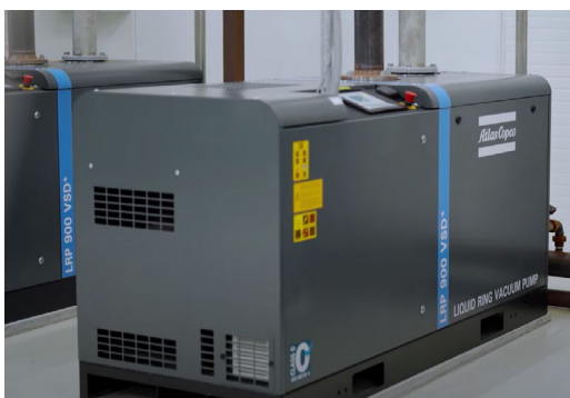
LRP VSD + intelligente vloeistofring-vacuümpomp van Atlas Copco
